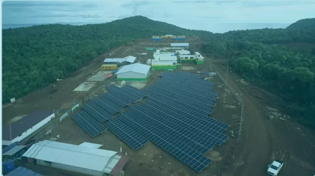
Xolare (SOLA) Rampungkan Proyek PLTS di Raja Ampat Sumber; Ist
